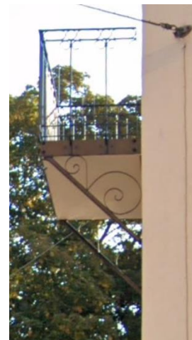
Balkong med konsoll
